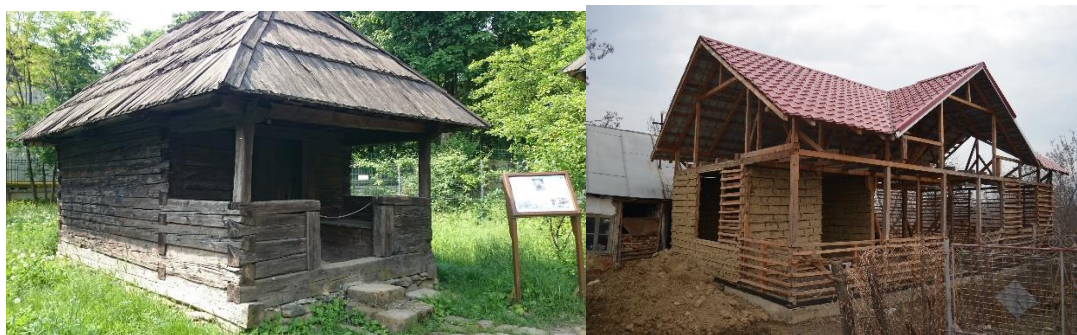
Fig. 1: Adaptarea structurii casei, datorită lipsei lemnului: Stânga [36] este tipică din zona montană (unde lemnul este ușor de găsit) și dreapta este într-o zonă de deal (unde lemnul este scump)
