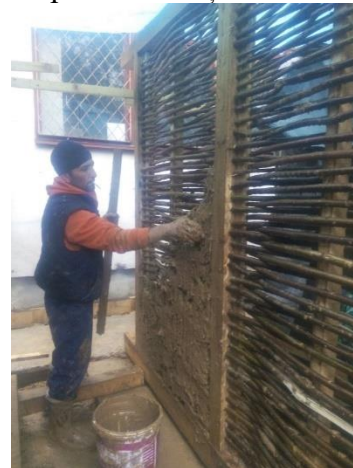
Fig. 145: Specimenul de tip 2 (S3) în timpul construcției – aplicarea pământului amestecat cu paie
