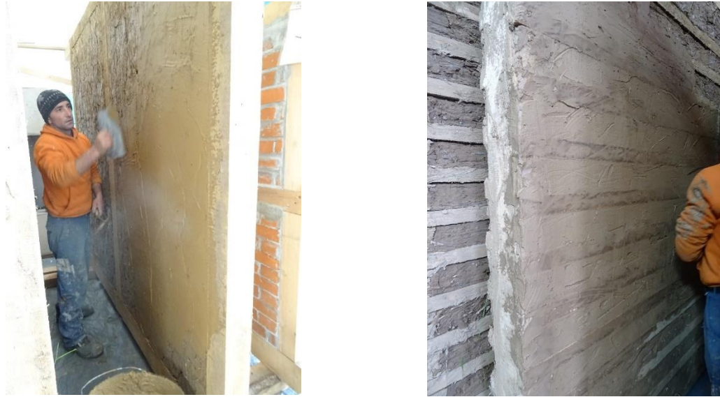
Fig. 149: La terminarea execuției pereților, după ce au fost lăsați să se usuce, a fost aplicat un strat fin de pământ (lut) pentru nivelarea suprafeței și umplerea fisurilor din contracția la uscare
