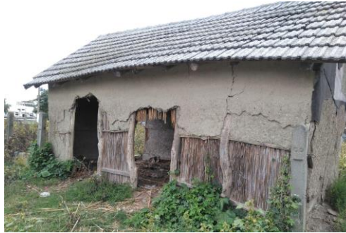
Tipul 2 – impletitura de nuiele (verticala)
