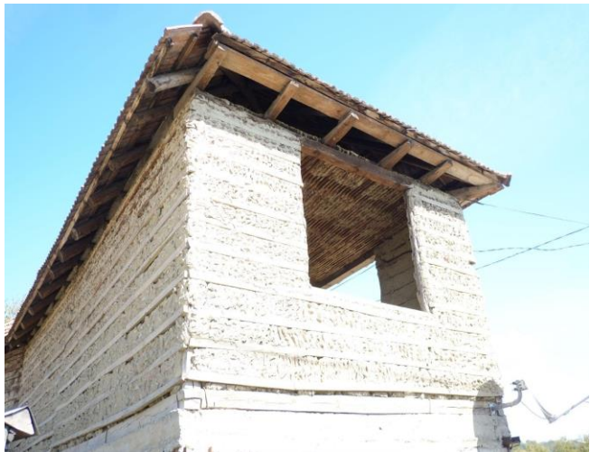
Tipul 3 – umplutura de pamant cu paie in leaturi orizontale
