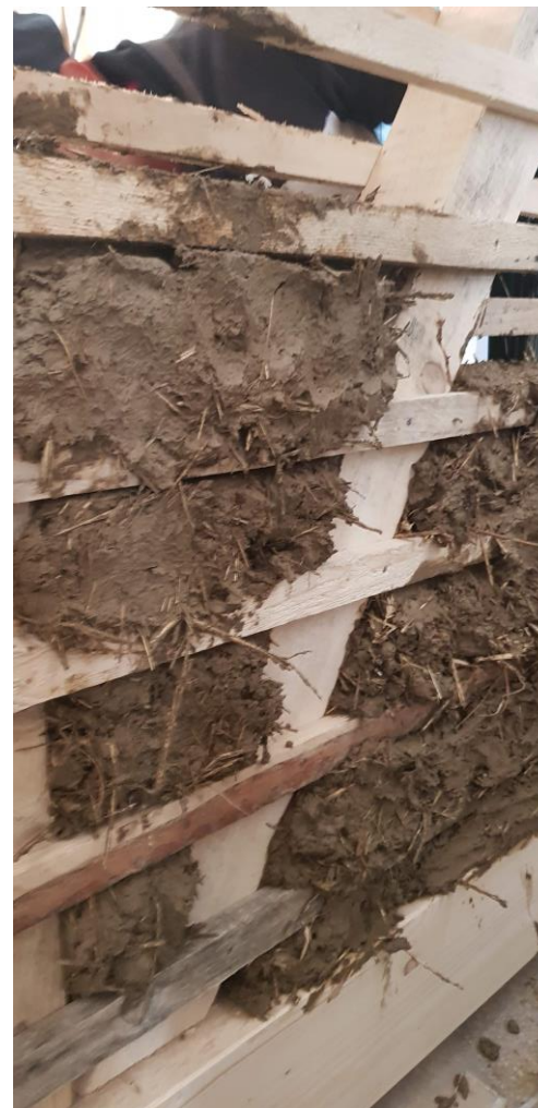
Tipul 3 – leaturi orizontale umplute cu pamant cu paie
