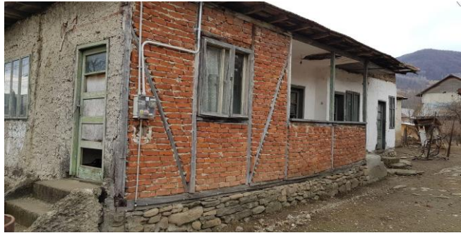
Tipul 1 – umplutura de zidarie de caramida de pamant
